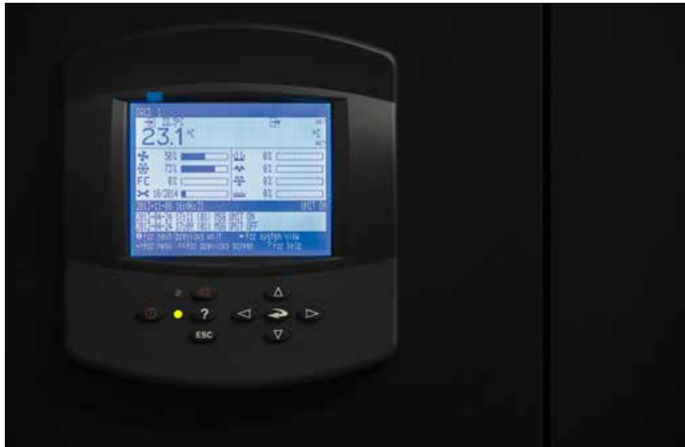
Bild 13. Display på en anläggning av typen precisionskyla.
