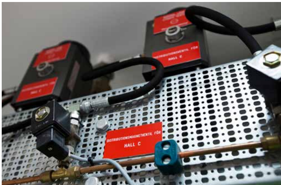
Bild 9. Utrustning för att fördela släck-gas till separata utrymmen.
