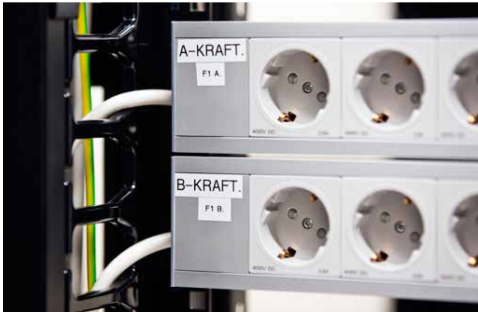
Bild 15. A- och B-kraft med fast montage i stativ. I detta fall används DC (likström) och det börjar förekomma fler servrar som matas med enbart DC istället för AC/DC på grund av energieffektivitet. Samma princip med A och B kraft gäller för både DC och AC/DC.
