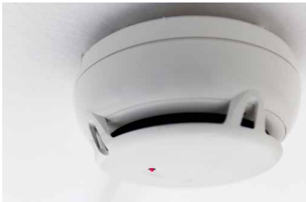
Bild 5. Optisk rökdetektor monterad i tak.
